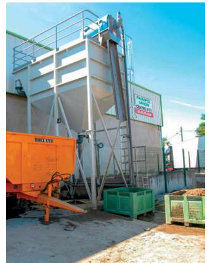
Décanteur lamellaire sur eaux terreuses. Réalisation Atlantique Industrie
